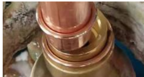
Сварка латунного узла распределителя жидкости
